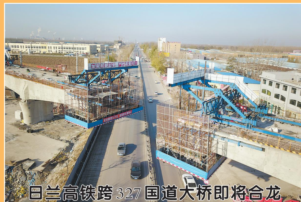
11月28日,在日兰高速铁路荷曲段跨327国道桥施工现场,工人们正紧张有序地在挂篮上进行现浇连续梁作业。目前,八号节块正在浇筑,在完成十号节块浇筑后,进行边跨合龙,预计春节前完成中跨合龙。据了解,该处属于日兰高速铁路荷曲段QHTJ-4段四分部,下一步将进行桥面附属施工,待架梁完成,通过沉降评估后进行无砟轨道底座板和轨道板施工。记者 李保珠 摄
