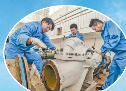
12月26日,东明县菜园集水库工作人员正在对供水设备进行升级改造,预计明年1月中旬改造完毕。据了解,该水库2017年建成,为加快推进城乡供水一体化建设,本月初,投资140万元,新增4台110千瓦新型抽水泵,区分工业与民用管道,加派抢险单元,加派值班人员,增加供水量,实现100%顺畅供水。目前,三个水库蓄水量920万立方米,升级改造后,服务群众从原来的37万人增加到80多万人。
