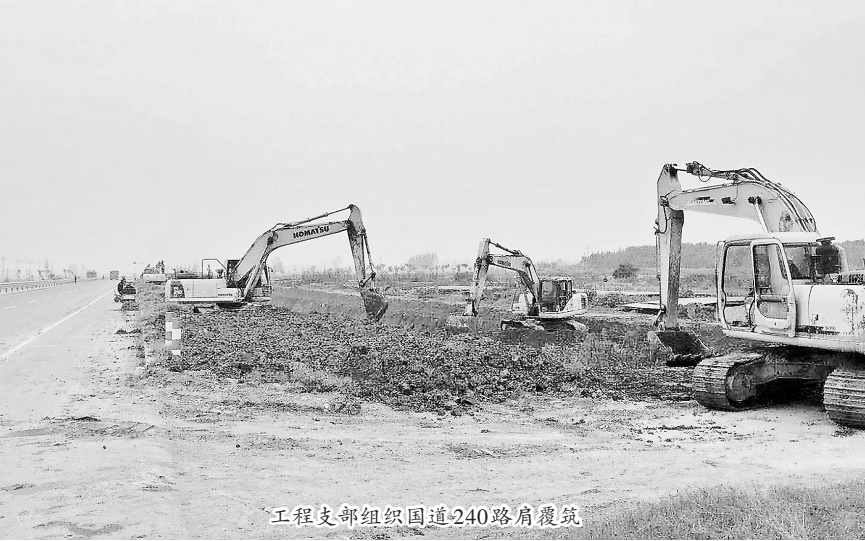
修护栏30处262米，补植道口桩389根。工程支部已完成城区道路总工程量的50%，国道240新建段7.8公里双侧路肩覆筑工作已接近尾声。
