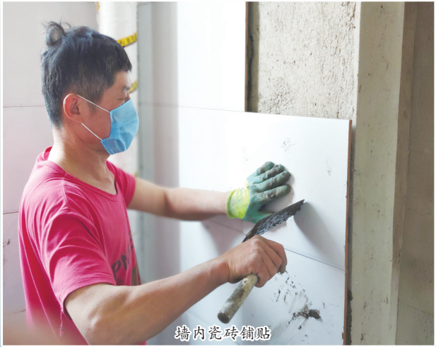
墙内瓷砖铺贴
