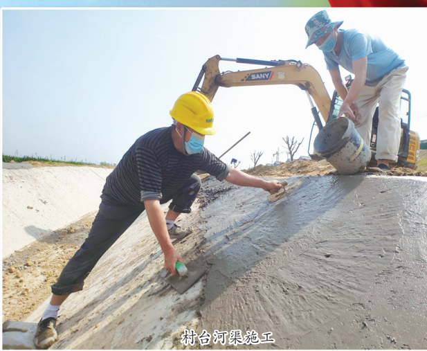
村台河渠施工
