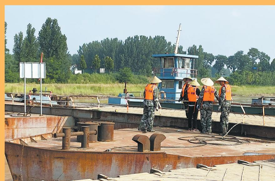
7月15日上午,东明县长兴集乡竹林新村黄河滩边,工作人员正在重新搭建浮桥。据了解,自7月1日起,黄河正式进入主汛期,菏泽境内11座浮桥全部拆除。近日,随着流量逐渐减小,黄河高村水文站流量已降至2000立方米每秒以下,经相关部门批准后,浮桥陆续恢复通行。目前,东明长兴集浮桥、鄄城董口浮桥、郓城苏阁浮桥等6座已经全部恢复通行,其余浮桥也在陆续恢复中。
