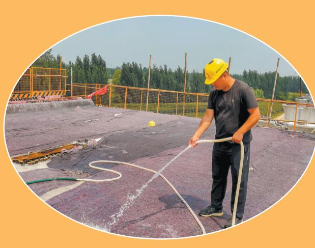
8月17日，鲁南高铁荷兰段跨S251省道连续梁施工现场，工人正在对连续梁进行养护（左图），为下一步预应力张拉做好各项准备工作。此次浇筑完成的连续梁为鲁南高铁荷兰段首座连续梁，位于牡丹区何楼街道办事处跨越S251省道处，属全线重点控制性工程之一，结构形式为40m+64m+40m。本次连续梁顺利浇筑为项目后续节点的顺利推进奠定了坚实基础。据悉，预计9月初，待连续梁全部合龙后，鲁南高铁荷兰段开始进行架梁施工。
