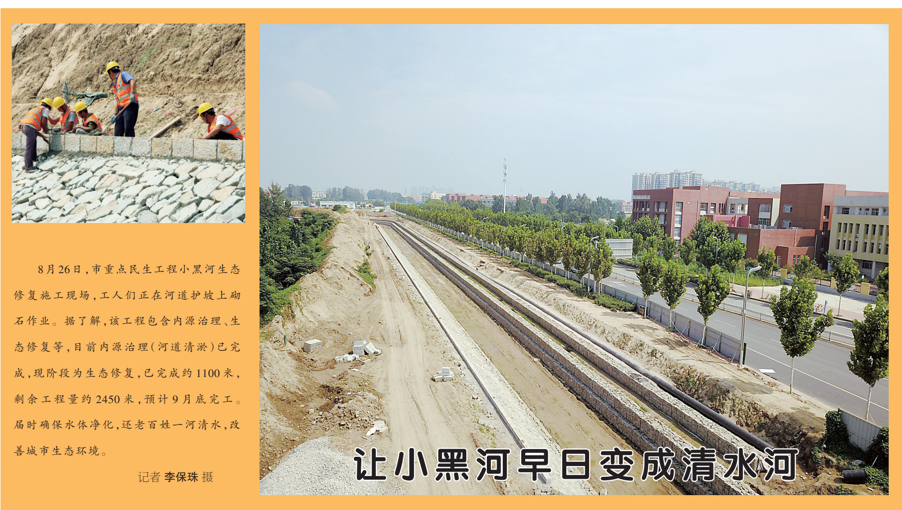
8月26日,市重点民生工程小黑河生态修复施工现场,工人们正在河道护坡上砌石作业。据了解,该工程包含内源治理、生态修复等,目前内源治理(河道清淤)已完成,现阶段为生态修复,已完成约1100米,剩余工程量约2450米,预计9月底完工。届时确保水体净化,还老百姓一河清水,改善城市生态环境。 记者 李保珠 摄
