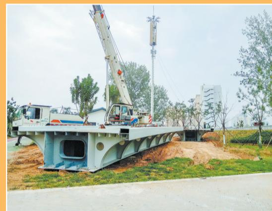
10月18日,人行天桥工程中华路(高平路)段施工现场,施工人员正在进行主梁吊装,目前已吊装完成约200米,预计本月25日完成主梁吊装。据悉,该天桥将以牡丹为主题,全长266米,总宽度为3.5米。建成后将有效缓解中华路与高平路段的交通压力,不仅缩短了中华路车辆通行时间,也为市民出行安全提供保障。同时,这座具有牡丹特色的过街天桥,也将成为中华路一道亮丽的风景线。
