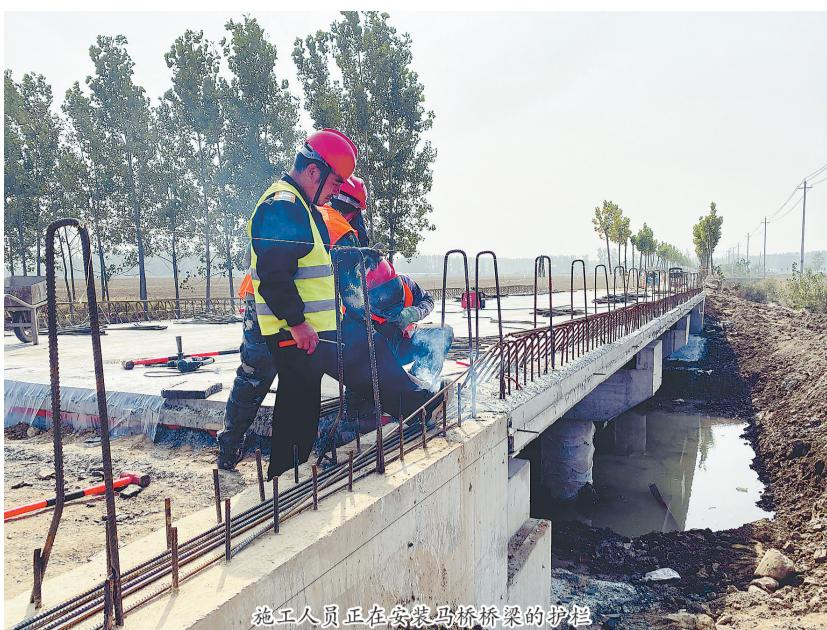
施工人员正在安装马桥桥梁的护栏
