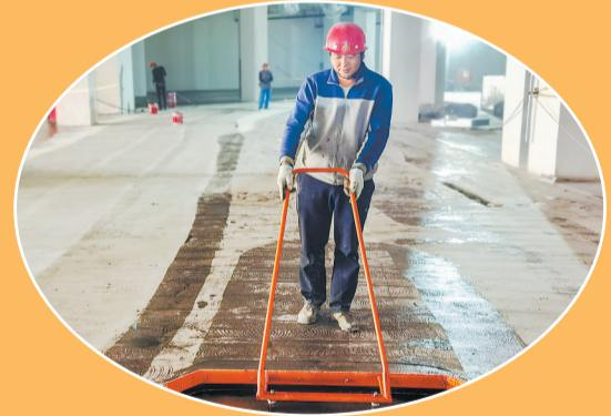
10月28日,市开发区人民南路日兰高速菏泽南出口处,省重点项目菏泽智慧冷城施工现场,施工人员正在鲜活低温配送中心进行环氧地坪漆铺设作业。目前项目一期主体全部完工,幕墙安装、室内外装修等配套接近尾声,预计11月份竣工,元旦前投入使用。据悉,项目采用“互联网+供应链物流”的设计理念,融合低温加工、中央厨房、净切菜处理、农产品收储等,完善周边20公里内生鲜供应链,为人们提供新鲜、健康的生活食材。
