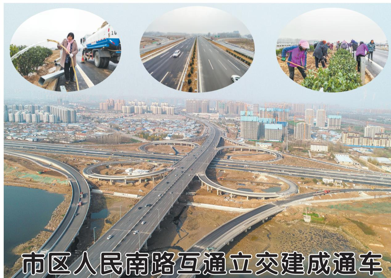
12月1日,市重点民生工程人民路与南外环互通立交桥主体工程全线建成通车,现场工人正在进行绿植栽种、养护作业。据了解,项目采用苜蓿叶形互通式立体交叉,分为上中下三层(人民路上跨、中间G240横穿和下部非机动车道)。主线设计速度80公里/小时,匝道设计速度40公里/小时。项目的建成解决了南北方向定陶区、曹县等县区到菏泽市区的交通通行拥堵问题,进一步提升菏泽南部城市发展空间,方便沿线居民出行。
