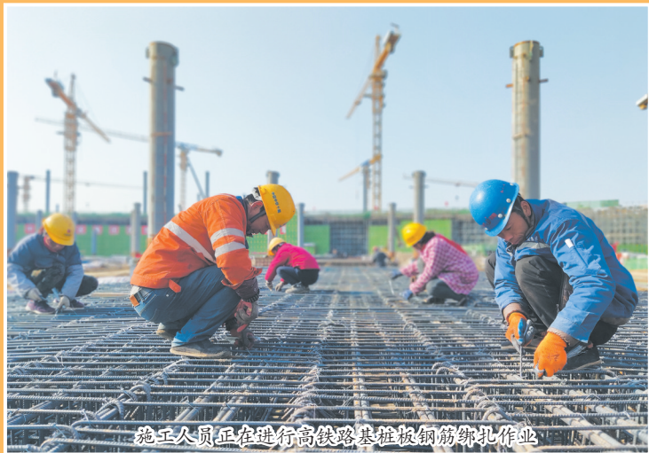
施工正在进行高铁路基堆载钢筋绑扎作业
