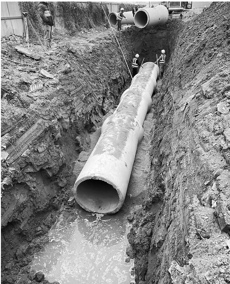
日前,曹县庄寨镇污水管网施工人员正在下埋污水管网。据悉,该镇在金鑫路、南环路等地段建管网总长48.48(km),并进行污(雨)水分离,预计今年6月底前后与新建第二污水处理厂对接,这将对改善镇区村庄、企业污水处理起到一定作用。
