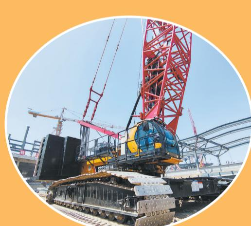
4月19日，在高铁菏泽东站施工现场，多台数百吨级履带式起重机正在站台雨棚现场进行装卸和安装作业。据了解，菏泽东站总建筑面积21万平方米，其中站房建筑面积5.9万平方米，站台雨棚面积4.6万平方米。站房主要结构共分为三层，分别是出站层、站台层和高架层，每层在局部设有夹层。目前，站房混凝土主体工程已全部完成，正在紧张推进站房钢结构屋盖及雨棚钢结构安装施工，该项施工预计6月份全部完成。
