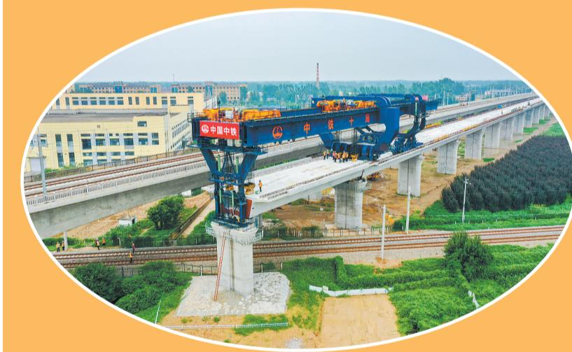
7月26日,京雄商高铁与鲁南高铁并行段架梁施工现场,运梁车配合提梁机将预制箱梁缓缓提起,经过提拉、平移和定位,精准将856吨的箱梁架到墩身上,整个过程约150余分钟。截至目前,京雄商高铁与鲁南高铁并行段累计架设129孔,完成该段箱梁架设的28%,墩身施工完成70%,箱梁预制完成40%,隧道桥梁、线路等各项工程正在高效有序推进中。
