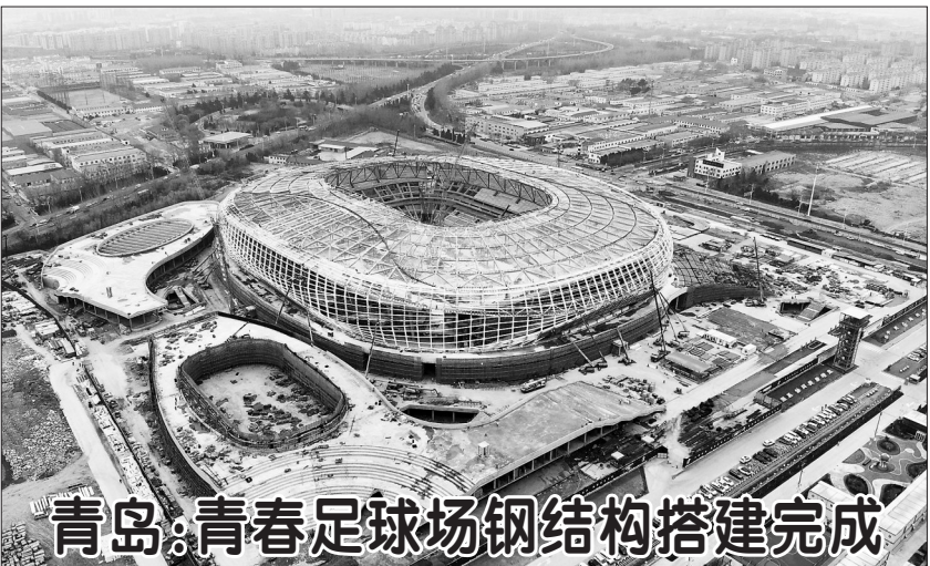
青岛:青春足球场钢结构搭建完成 近日,位于山东省青岛市城阳区的亚洲杯青岛青春足球场钢结构搭建完成,项目全面转入幕墙、机电安装以及装饰装修阶段,预计今年年底竣工交付。 据介绍,建筑面积约19.4万平方米的青岛青春足球场将承办2023年亚洲杯部分比赛。 新华社记者 李紫恒 摄
