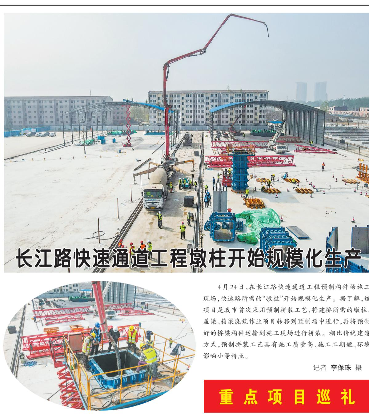
4月24日，在长江路快速通道工程预制构件场施工现场，快速路所需的“墩柱”开始规模化生产。据了解，该项目是我市首次采用预制拼装工艺，将建桥所需的墩柱、盖梁、箱梁浇筑作业项目转移到预制场中进行，再将预制好的桥梁构件运输到施工现场进行拼装。相比传统建造方式，预制拼装工艺具有施工质量高、施工工期短、环境影响小等特点。
