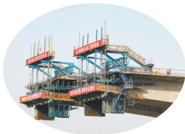
7月7日,在濮阳至湖北新乡高速公路黄河特大桥项目施工现场,建设者们冒酷暑在进行挂篮连续梁施工。目前,桥梁下部结构全部完工,跨黄河主桥现浇连续梁累计完成512节,全桥1120根50米T梁架设完成,大堤内引桥顺利合龙,其余工程正在按计划有序推进中。据了解,新建黄河大桥竣工后,将有力提升山东、河南两地交通格局和城市格局,改善黄河两岸民生条件,打通两岸百姓的经济往来,对改善黄河农产品外运、物流配送等关键环节提供了强有力的支撑,有力推动黄河流域经济社会高质量发展。 记者 李保珠 摄
