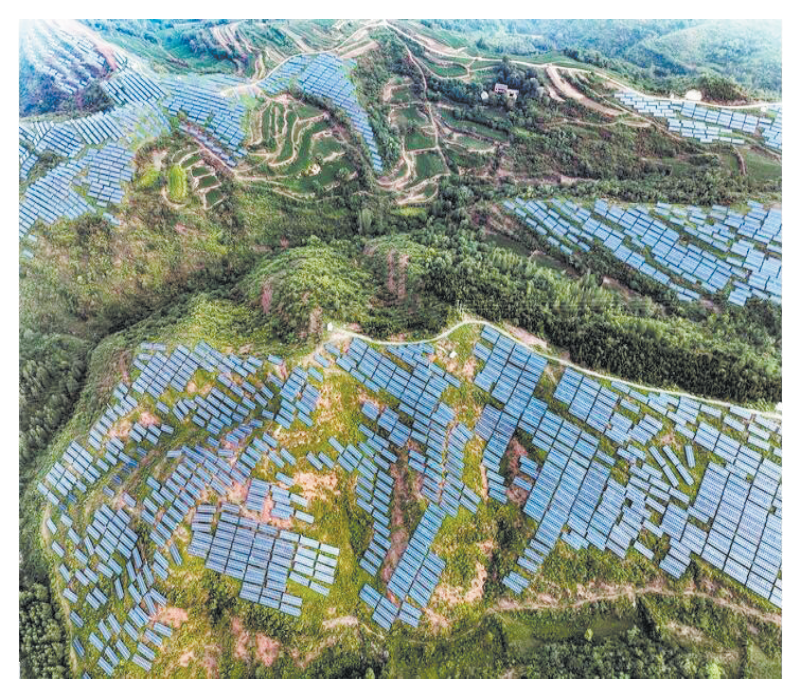
▲这是8月4日在河南省济源市大峪镇拍摄的一处光伏电站(无人机照片)。
