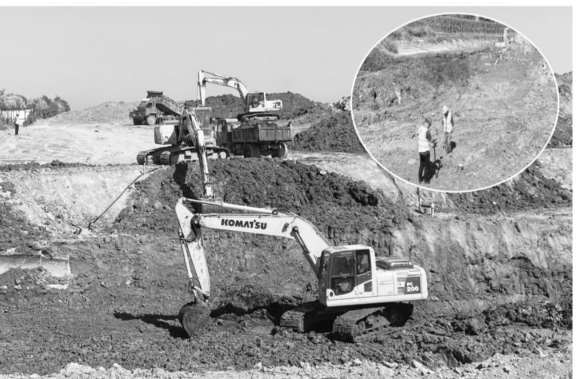
近日,记者在巨野县洙水河中段治理工程现场看到,工人们正在操纵大型机械紧张施工。据了解,该项目是省“十四五”水利发展规划中的供水保障重点工程之一,也是省黄河流域生态保护和高质量发展规划重点项目之一。项目总投资1.18亿元,主要建设内容包括疏挖河道16.17公里,改建、新建河道建筑物22座。工程完工后,可清淤疏浚84万立方米,年增加引调水量1500万立方米,保护农田4.5万亩,为乡村振兴注入新的活力。 记者 刘志华 摄
