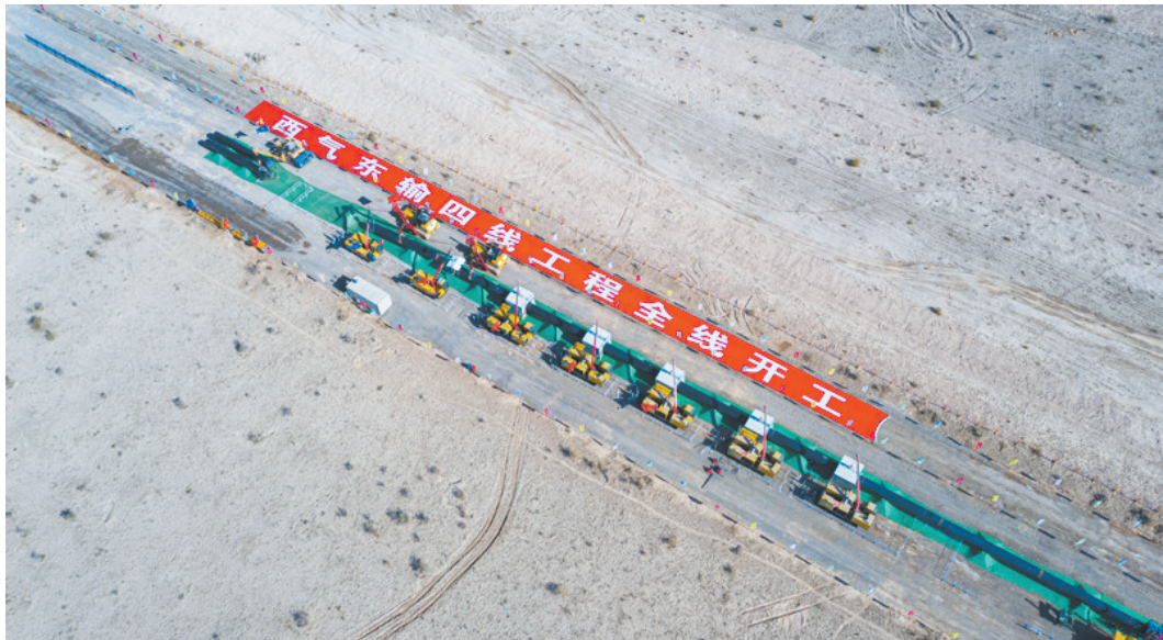
西气东输四线工程建设现场
