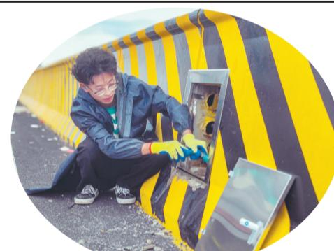
5月9日,在人民路北延项目主线桥上,乌黑油亮的沥青路面、白色的道路标线、双向车道向北不断延伸……路灯、信号灯、交通标线一应俱全。施工场,工人们正在进行路灯配电箱安装作业。
