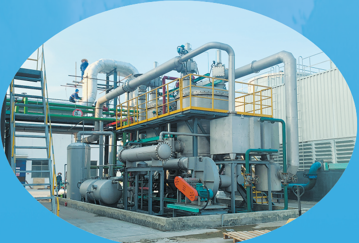
越兴化工有限公司内的冷凝洗脱附装置
