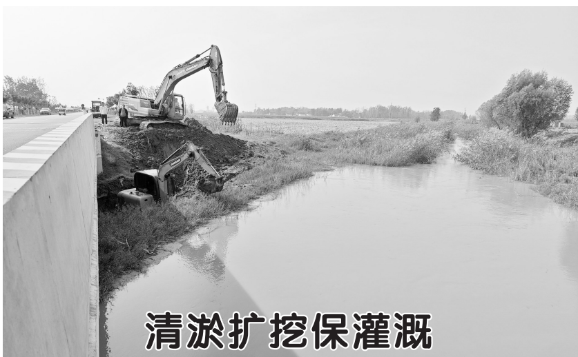
清淤扩挖保灌溉 近日，在鄄城县临濮河河沙治理工程施工现场，挖掘机正在对路边的排灌渠进行清淤扩挖。据了解，该项目今年8月份已被列为省重点水利工程，总投资1.28亿元，治理长度为21.65千米，预计年底前完成河道清淤工作，为明年春耕打下坚实基础，确保灌溉、供水、排涝等功能正常发挥。 记者 李保珠 摄
