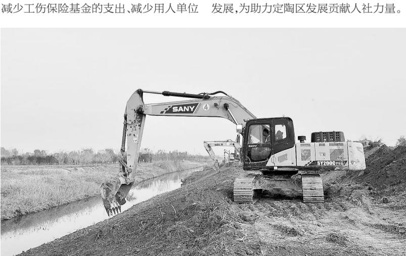
▲11月28日,在东鱼河北支(鲁西新区段)治理现场,数十台挖掘机正在平整坡道。据了解,东鱼河北支位于洙赵新河和东鱼河之间,是淮河流域东鱼河的最大支流,兼行洪、排涝、灌溉等功能,流经成武县、定陶区、鲁西新区、东明县两区两县。本次东鱼河北支治理(鲁西新区段)总长14.01km,共治理建筑物27座,其中,新建涵闸9座,改建涵闸6座,新(改)建桥梁2座,维修桥梁9座,维修泵站1座。该工程自2023年10月初开工,工期15个月。
