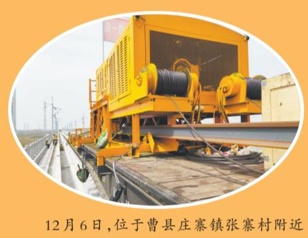
12月6日,位于曹县庄寨镇张寨村附近的荷兰高铁施工现场,工人们正进行无砟轨道铺设作业。目前,荷兰高铁庄寨站至兰考南站段左线已铺设25公里,预计2024年1月中旬完成全线的轨道铺设任务。据了解,荷兰高铁是国家“八横八纵”高铁网的重要区域连接线,是日(照)兰(考)高铁的重要组成部分,建成后日兰高铁将全线通车,与郑徐高铁连接起来,对改善鲁豫两省区域交通运输条件、促进社会经济快速发展具有重要作用。
