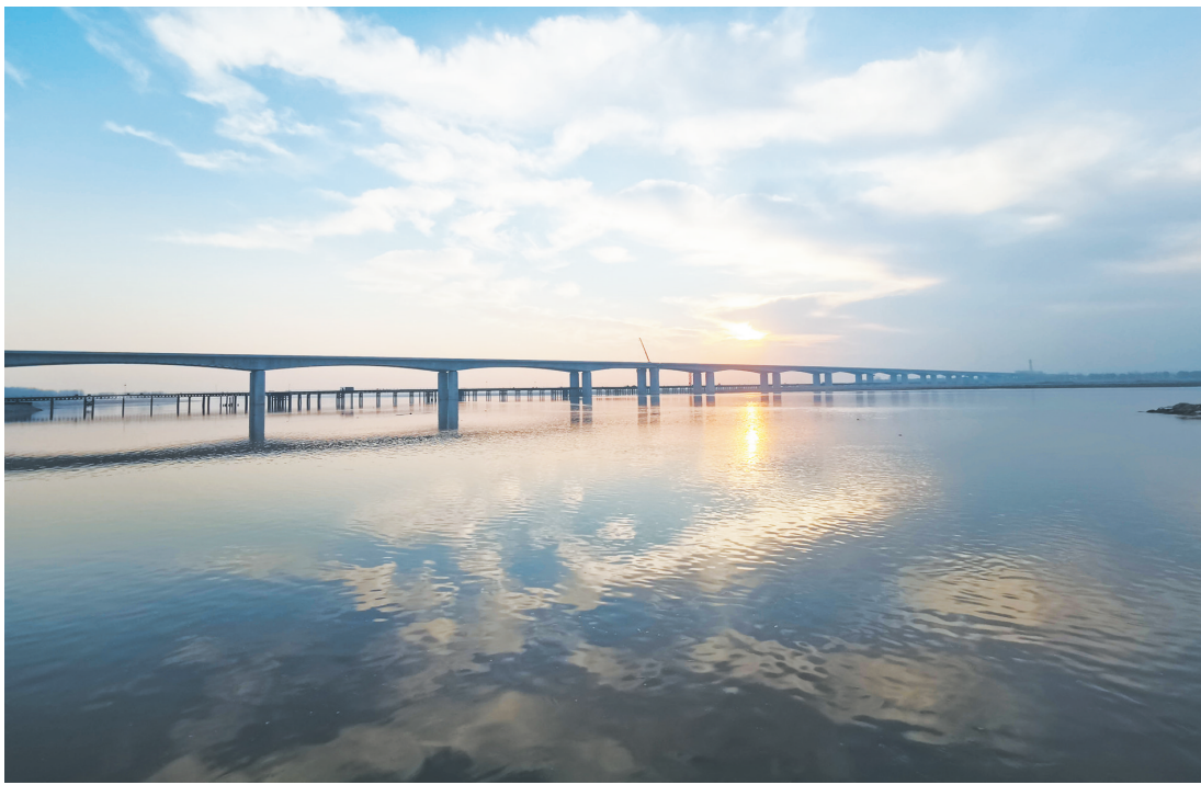
图为建设中的S304鄄城县黄河公路大桥。 S304鄄城县黄河公路大桥路线全长14.065公里,主桥全长2公里,双向六车道。下部结构采用箱型墩,承台及群桩基础,上部结构采用预应力混凝土变截面连续箱梁,预计年底竣工。该项目作为跨越黄河的重要通道,建成后连接起豫鲁两岸地区干线路网,构建综合交通运输体系,对加强两地联系,助推黄河流域高质量发展具有重要作用。 记者 焦同帅 摄
