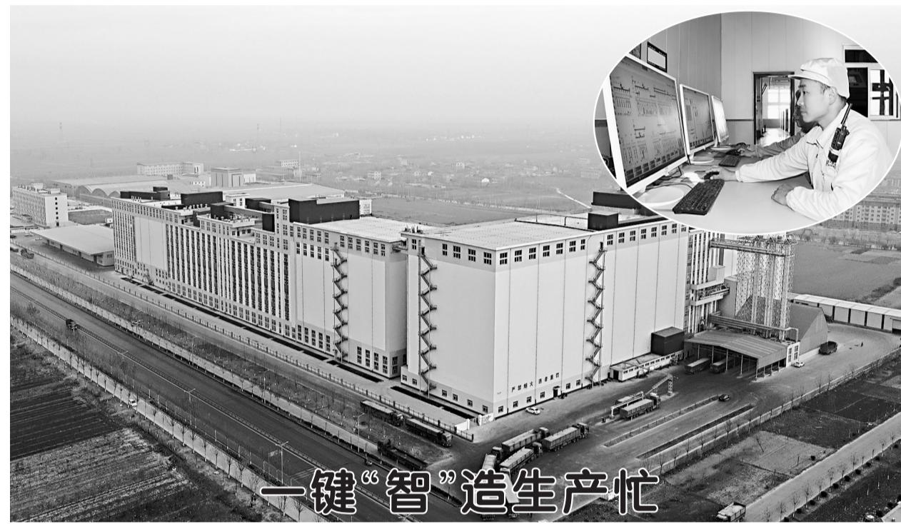
近日,在五得利集团东明面粉有限公司总控室内,工人通过操作电脑控制台管控机械设备进行生产作业。据了解,该企业位于东明县武胜桥镇,拥有4个大型制粉车间,11条现代化面粉生产线,日加工小麦6000吨,生产规模、产品销量全国遥遥领先。企业积极推进智能工厂建设,制粉车间全部采用世界最先进的瑞士布勒集团的设备,能做到所有产品的生产全过程追溯,指标自动报送。同时,公司引入先进的管理系统,自主搭建了具有独立知识产权的“织布鸟”物流信息平台,实现了物流信息的实时监控和高效调度,确保了产品从生产到销售的顺畅流通。
