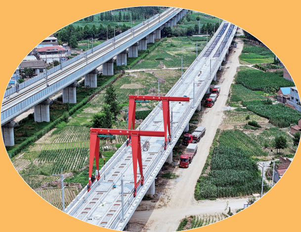
雄商高铁菏泽段启动无砟轨道铺设
