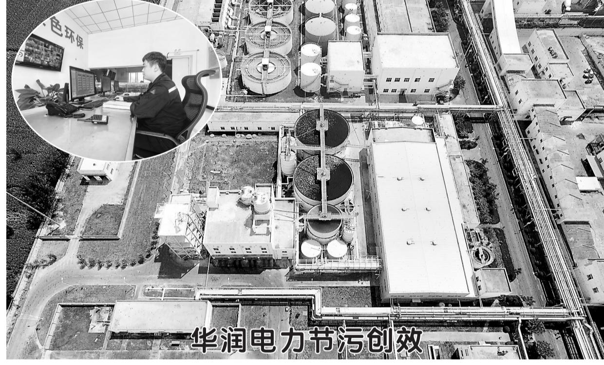
7月22日,在牡丹区皇镇街道的华润电力(菏泽)有限公司,技术人员正在监测全厂废水排放系统运行情况。据悉,该系统分为循环水排水处理、脱硫废水处理和蒸发结晶三个模块,每年可回收清洁水量约200万吨,减排化学需氧量(COD)60吨,产生8000吨工业级氯化钠,实现资源化利用,环境和社会效益显著。
