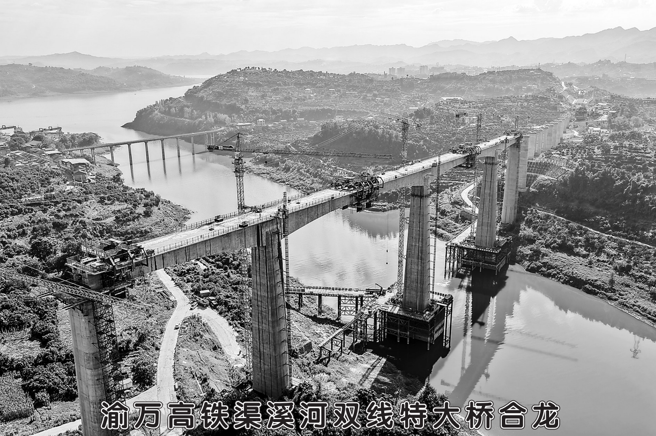
这是8月18日拍摄的渝万高铁渠溪河双线特大桥施工现场（无人机照片）。当日，由中国铁建大桥局承建的重庆至万州高速铁路（渝万高铁）渠溪河双线特大桥顺利合龙。渝万高铁渠溪河双线特大桥位于重庆市涪陵区珍溪镇，横跨长江支流渠溪河，全长约953米，是全线重难点工程。渝万高铁是我国“八纵八横”高铁网包（银）海、京昆通道的组成部分，正线全长251公里，设计时速350公里。
