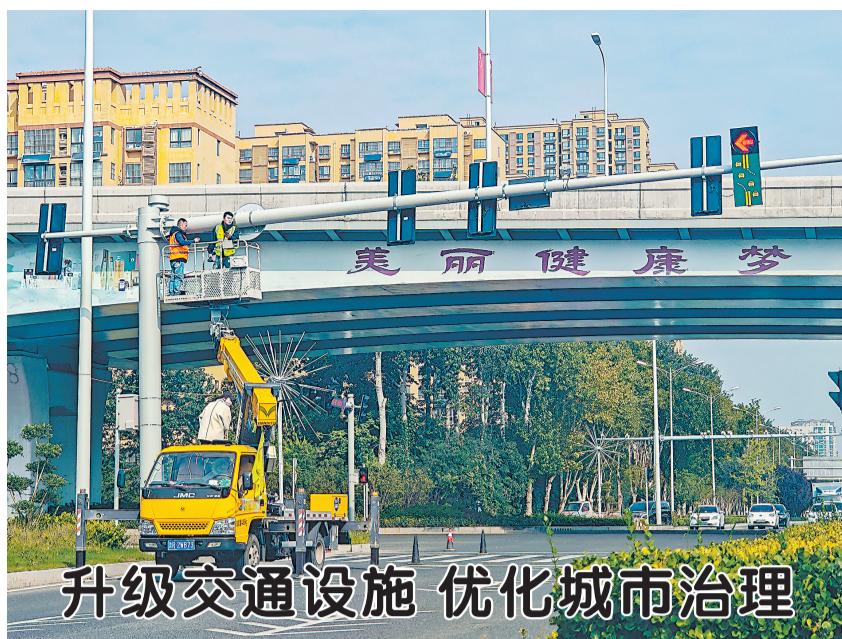
近日，在菏泽市长江路及广州路交叉口南侧，工作人员正在对交通信号设施进行维修与升级作业。
