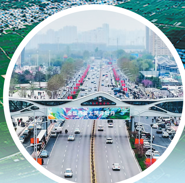
人民路过街天桥投入使用
