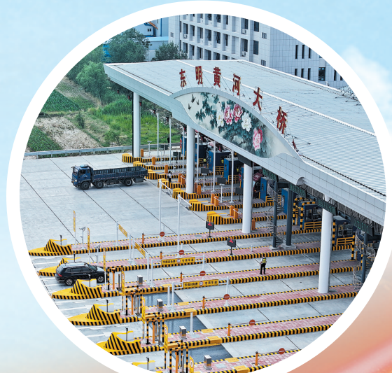
东明黄河公路大桥改扩建工程完工
