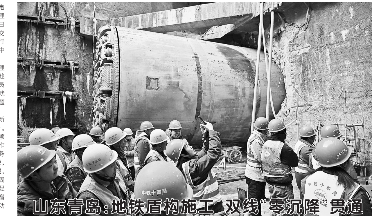
山东青岛:地铁盾构施工 双线“零沉降”贯通
