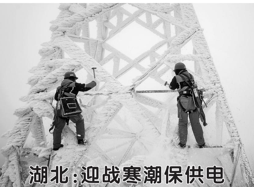
1月21日，在鹤峰县走马镇，抢修人员在35千伏电力线路铁塔进行人工除冰作业。
