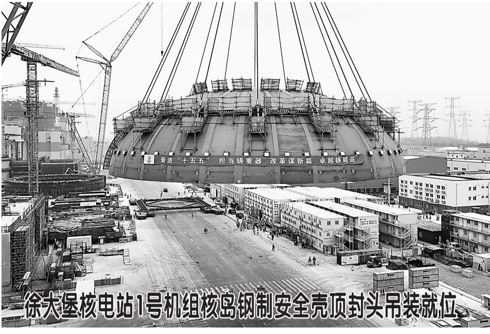
徐大堡核电站1号机组核岛钢制安全壳顶封头吊装就位
