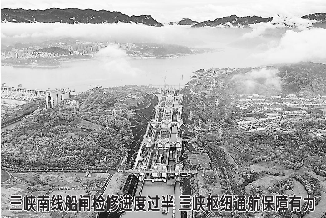
三峡南线船闸检修进度过半 三峡枢纽通航保障有力
