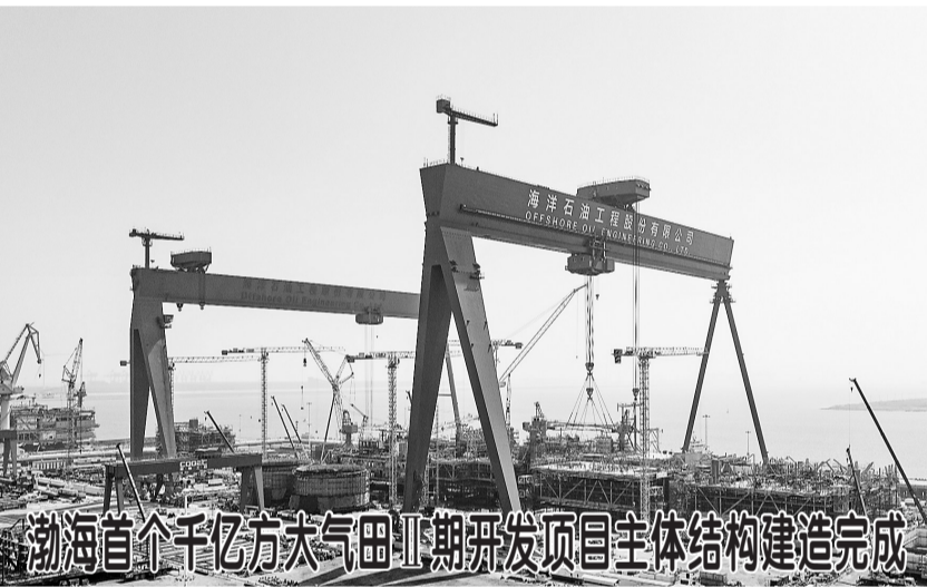
这是6月2日拍摄的渤中19-6气田二期开发项目建造现场(无人机照片)。6月2日,渤中19-6气田二期开发项目3座平台主体结构在海油工程天津智能制造基地建造完成,标志着渤海首个千亿方气田二期开发项目进入加快建设阶段。渤中19-6气田位于渤海中部海域,已探明天然气地质储量超2000亿立方米、石油地质储量超2亿立方米,是我国东部第一个大型、整装、千亿方大气田。I期开发项目于2023年11月投产,II期开发项目计划新建3座井口平台、3座导管架。新华社记者 赵子硕 摄
