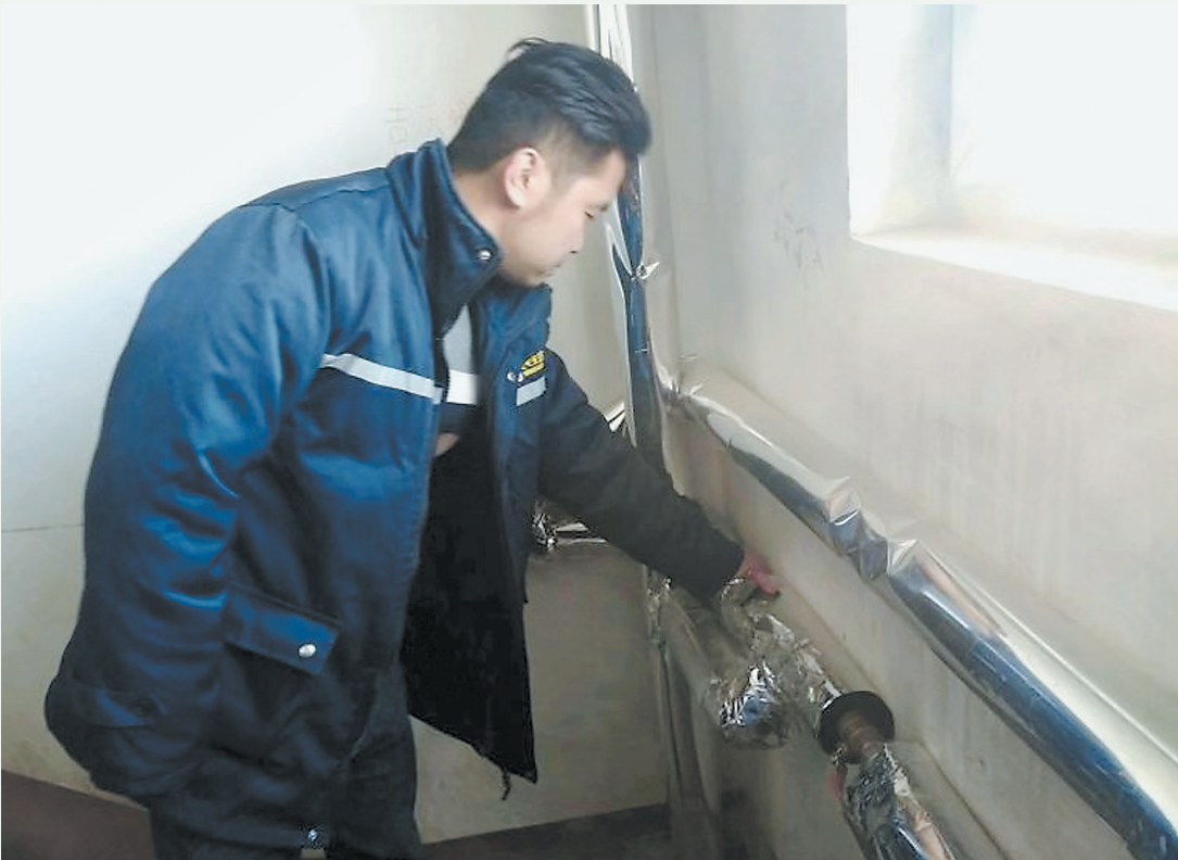
热力公司工作人员检查供暖设施
