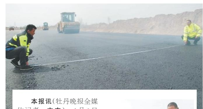
本报讯(牡丹晚报全媒体记者 文杰) 4月6日上午,在万华产业园道路建设现场,鄄城县交通运输局中通公司施工科科长郭晓冬等4名工程技术人员,正指挥两台大型摊铺机进行油层铺设,两台大型压路机紧随其后进行压实,整个施工现场呈现出一派紧张忙碌、热火朝天的景象(如图)。
