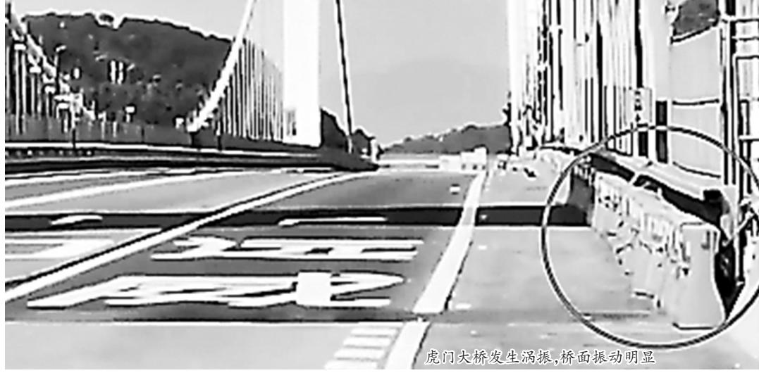
虎门大桥发生涡振,桥面振动明显
