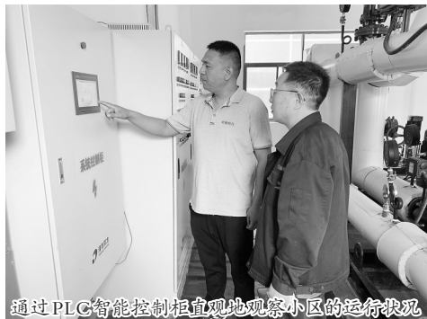
通过PLC智能控制柜直观地观察小区的运行状况
