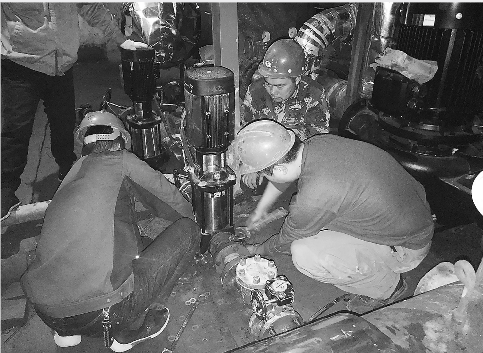
上图:热力工作人员在菏泽帝都花园小区更换循环泵,以提升集中供暖效果。
