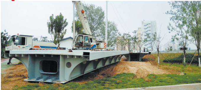
天桥剩余部分箱梁正陆续架设安装
