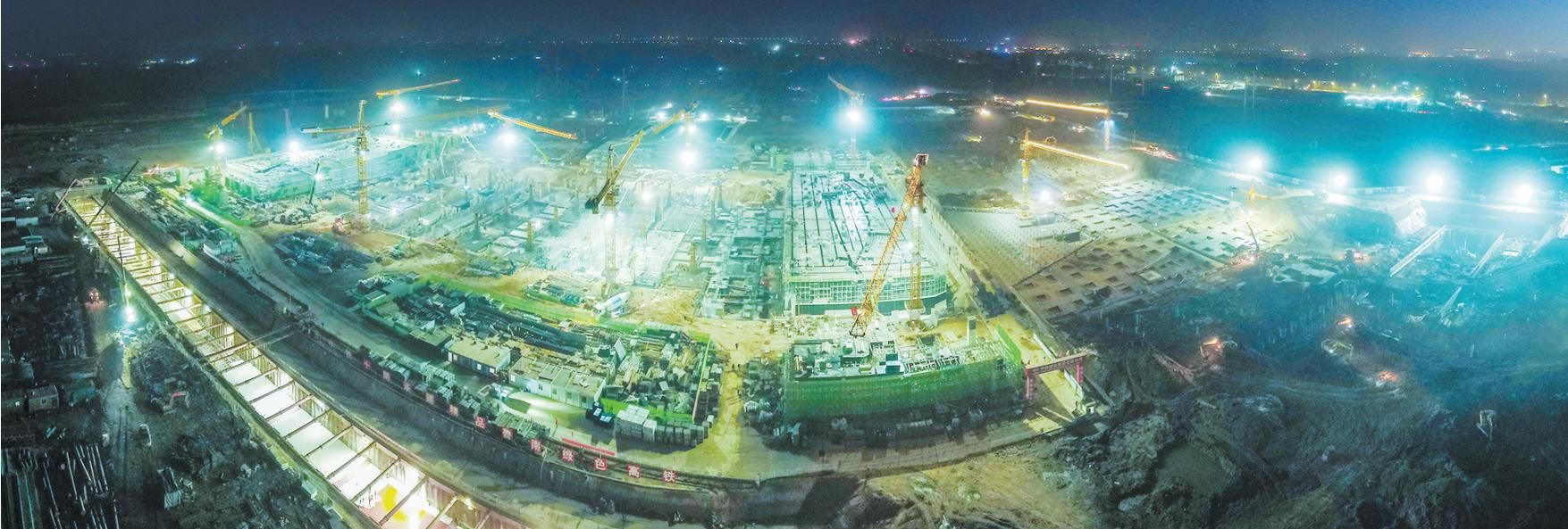
10月29日晚,菏泽(高铁)东站房施工现场灯火通明,运输车、挖掘机、混凝土泵车、塔吊等在各区域照常作业。为保证工期,施工方中铁建设集团有限公司鲁南高铁菏泽东站项目部组织1200余名作业人员和90余名管理人员24小时不间断施工。根据计划,站房混凝土主体结构将于本月底封顶,2021年5月底完成金属屋面施工,7月底具备联调联试条件,8月底完成装修作业,9月底具备静态验收条件。菏泽东站站场共15线6个站台。记者 李保珠 摄
