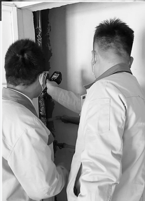
上图:热力工作人员检修供暖管道。
