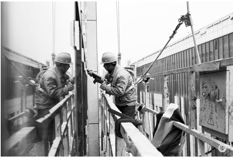
图①:正在建设中的市档案馆(含城建档案馆)外景。 图②:场馆内部一角。 图③:工作人员在进行内部装修施工。 图④:楼体玻璃幕墙施工即将完成,工人在进行收尾工作。
