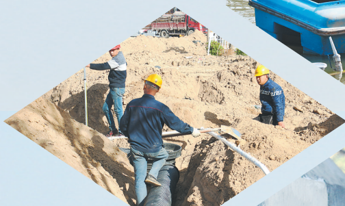
铺设地下管道
