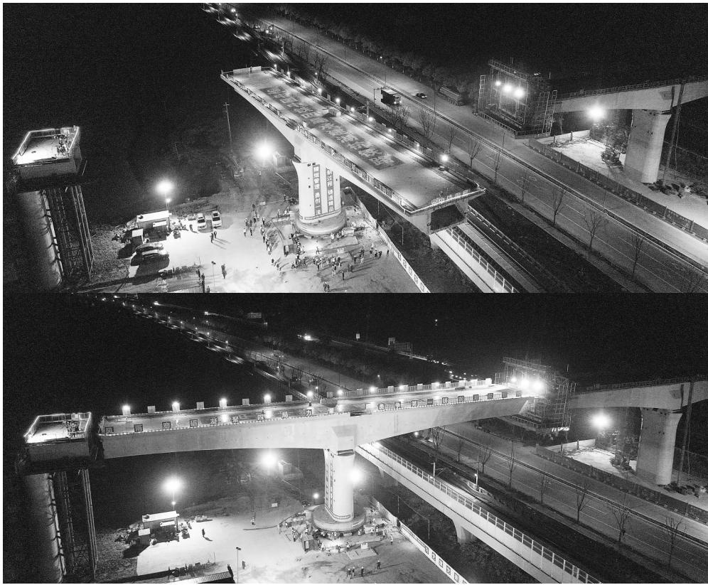
4月21日凌晨,湖杭铁路大圩里特大桥上跨杭临城际铁路、杭瑞高速、G329国道连续梁逆时针转动82度,安全跨越既有线,实现精准对接到位,这是湖杭铁路首个成功转体的连续梁。湖杭铁路设计速度350公里/小时,是“轨道上的长三角”重要节点工程,2022年杭州亚运会重点配套工程。新华社发
