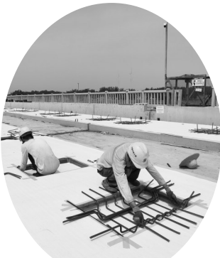
无砟轨道凹槽钢筋绑扎作业
